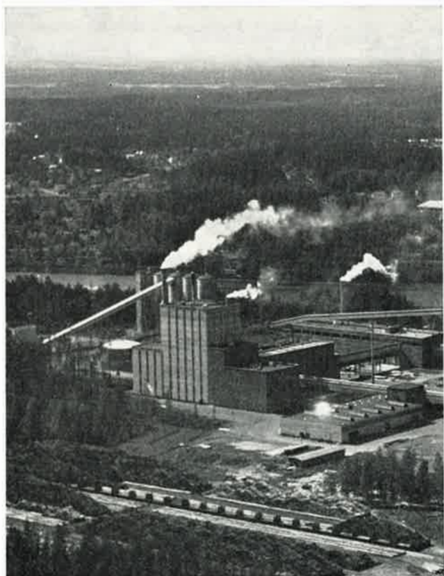
Kuvassa etualalla Kuusanniemen sulfaattiselluloosatehtaan soodakattilalaitos
