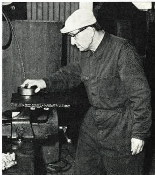
Kaarlo Salmen töihin kuuluu myös venttiilien laakereiden hionta karbiditehtaan korjauspajalla
