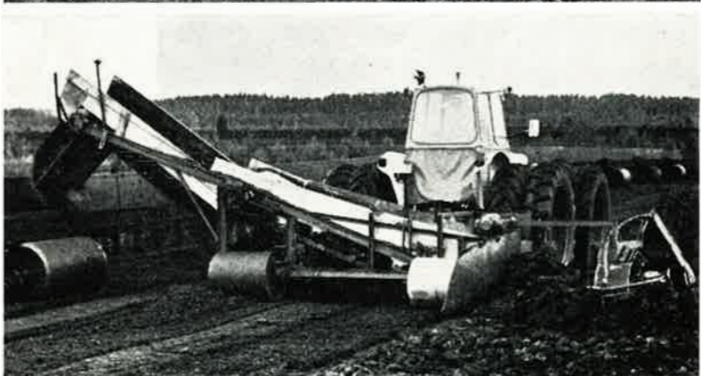
Uusi kuormaaaja liikkuu kokoojakoneen pitkän kuljettimen vierellä
