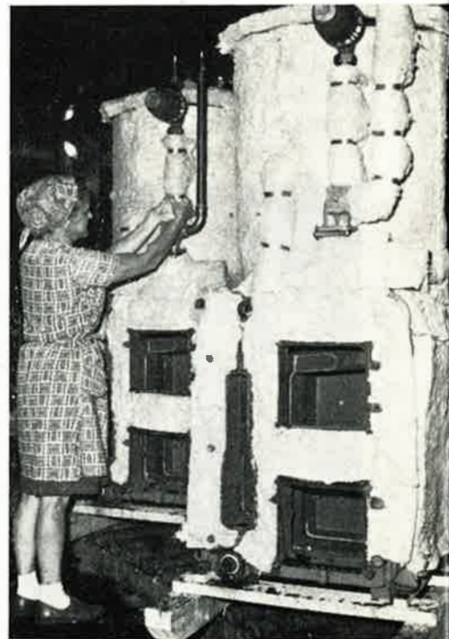
Vas. Kauko Liljegren ja Kustaa Gustafsson yhdistämässä Inari-kattilan valurautaisia liitteitä kartionipoilla. Puristus tapahtuu hydraulisesti.
