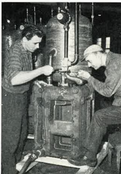
Vas. Kauko Liljegren ja Kustaa Gustafsson yhdistämässä Inari-kattilan valurautaisia liitteitä kartionipoilla. Puristus tapahtuu hydraulisesti.
