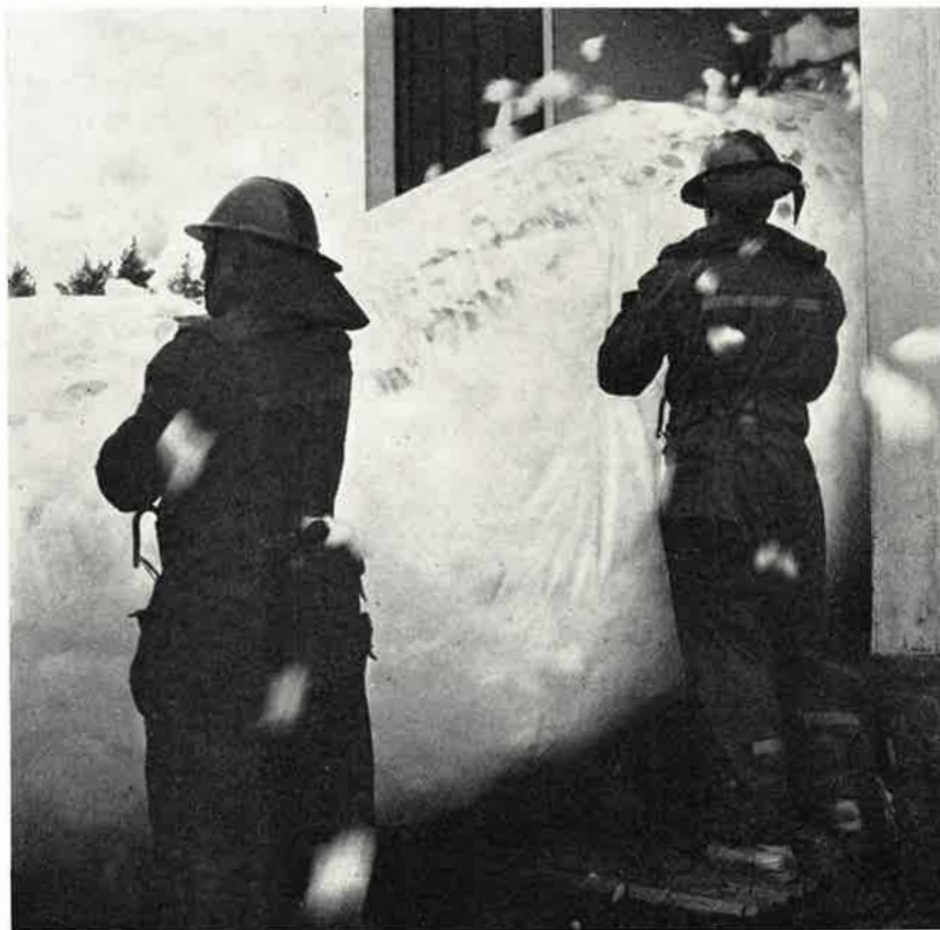
Vahto ohjataan kohteeseensa paksua muoviputkea myöten
