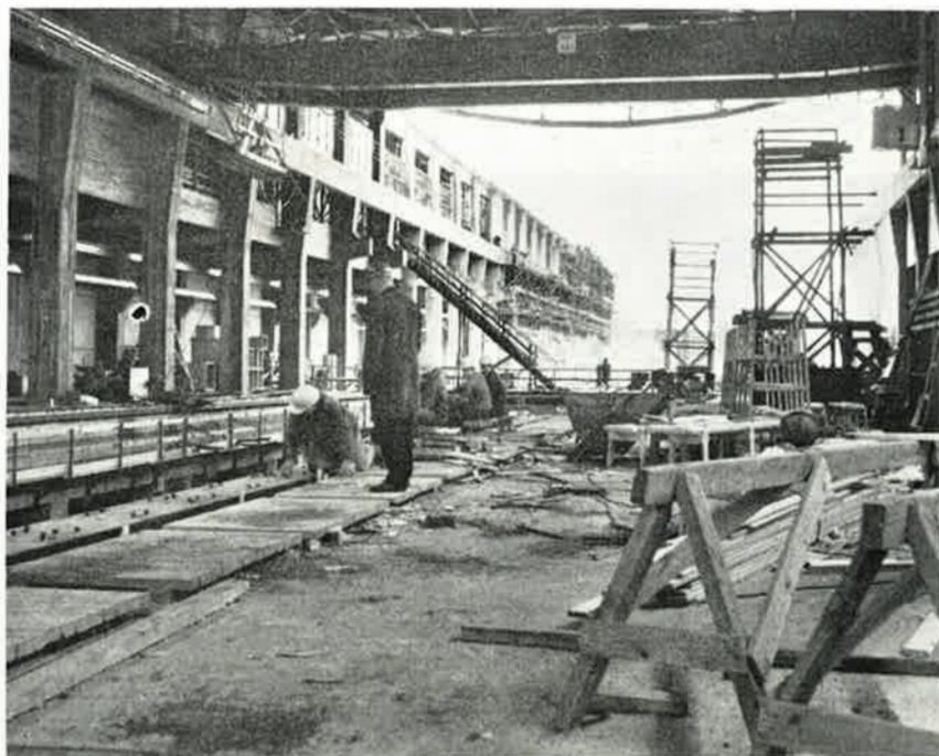
Rakentamisen painopiste on siirtynyt varaston puoleiseen päähän
