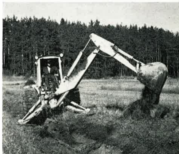
Peltojen perusparannuksen yhteydessä kaivettiin piiriojat, joita kuvassa urakalla suorittamassa Lauri Venäläinen
