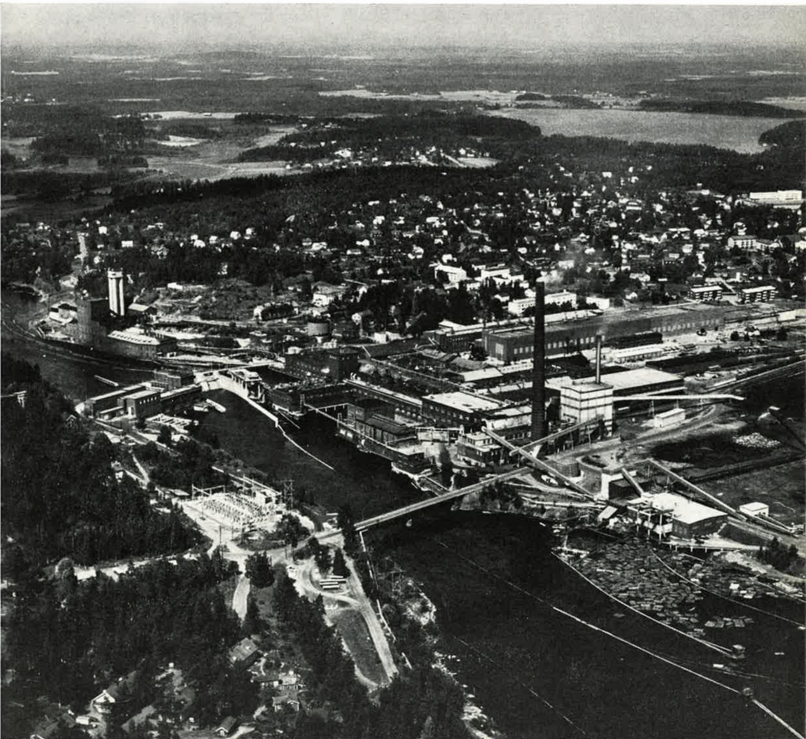
Voikkaan uusi paperikonehalli näkyy kuvassa höyryvoimalaitoksen savupiippujen takana
