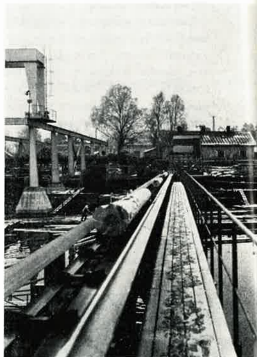
Kuoritut tukit siirretään tukkialtaan yli toiselle puolelle, jossa varsinainen lajittelija sijaitsee
