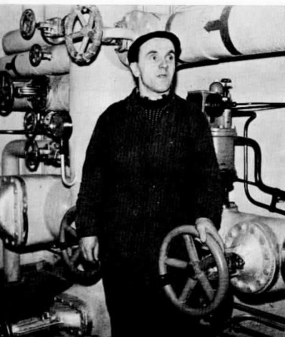
Päáluottamusmies Aaro Torvinen työpaikallaan Juantehtaan höyryjakokeskuksessa. Hän on toiminut Juantehtaan pääluottamusmiehenä syksystä 1967 alkaen.
