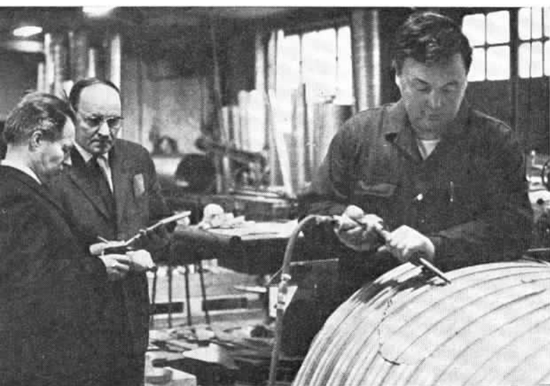
Peltiseppä Kaj Westerlund (oik.) tekemässä reikää pyöreään kanavaan. Turvallisuus-päällikkö Vilho Räsänen (vas.) ja ylityönjohtaja Erik Johansson melumittauksia suorittamassa.
