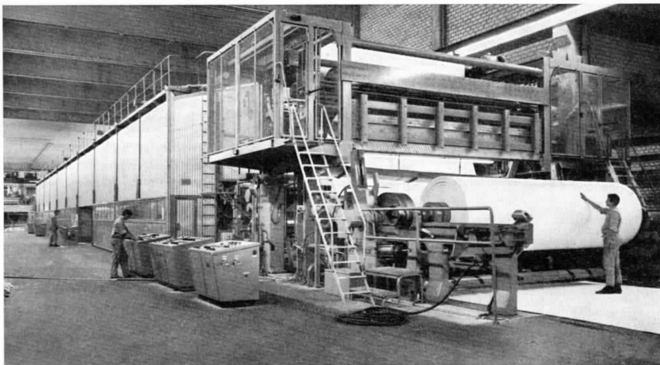
Selluloosan purkaus suoritetaan tehtaan omassa laiturissa. Paperikone 1:n toimittanut Oy Wärtsilä Ab. Koneen työleveys on 450 cm ja maksiminopeus 600 metriä minuutissa.
