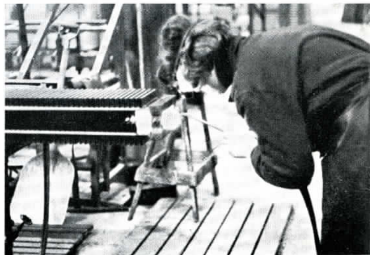
Hitsaaja Marja-Liisa Toivonen suorittamassa kaksinkertaisen radiakonvektorin yhteenhitsausta
