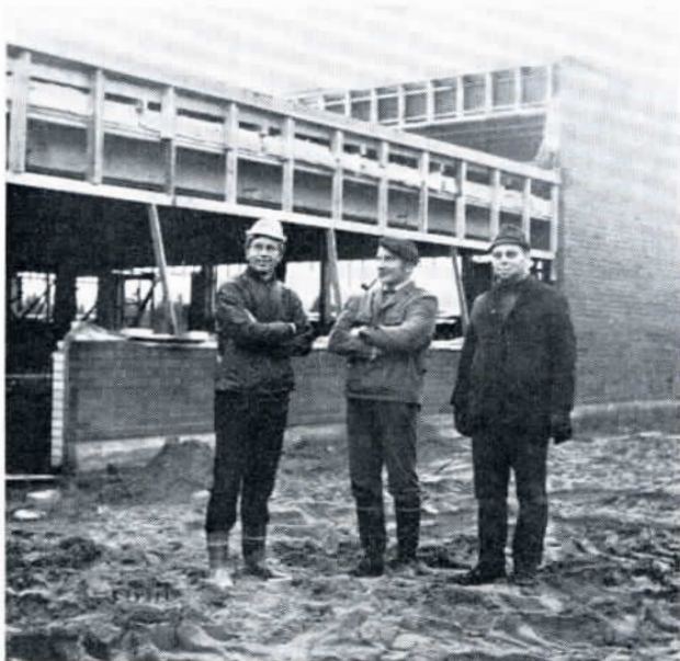
Kahdeksan osakaskunnan yhteinen Juankosken ammattikoulu valmistuu toukokuussa 1973. Kuvassa oik:ltä työmaan vastaava rakennusmestari Erkki Silainen, työmaan valvoja, rakennusmestari Tauno Kuikka ja ins. Esko Hynninen.
