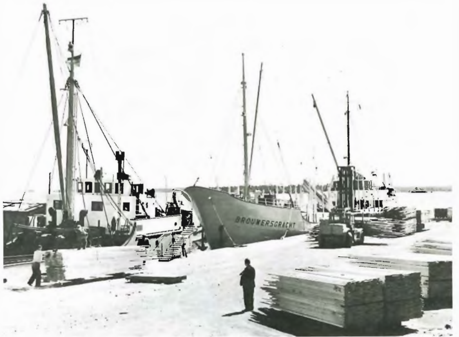
Sahatavaran lastausta Hallan omassa laiturissa, joka valmistui v. 1959. Laituri on 400 metriä pitkä ja siihen johtaa mereltä seitsemän metrin syvyinen väylä.
