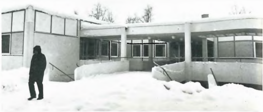
Sisäänkäynti uuteen työterveyskeskukseen tapahtuu Marskinkadulta, hammaslääkärin vastaanotolle päästään Lauttakadun puolelta. Fysikaalista hoitoa saavat pääsevät kätevimmin sisään pääoven oikealla puolella olevista ovista.
