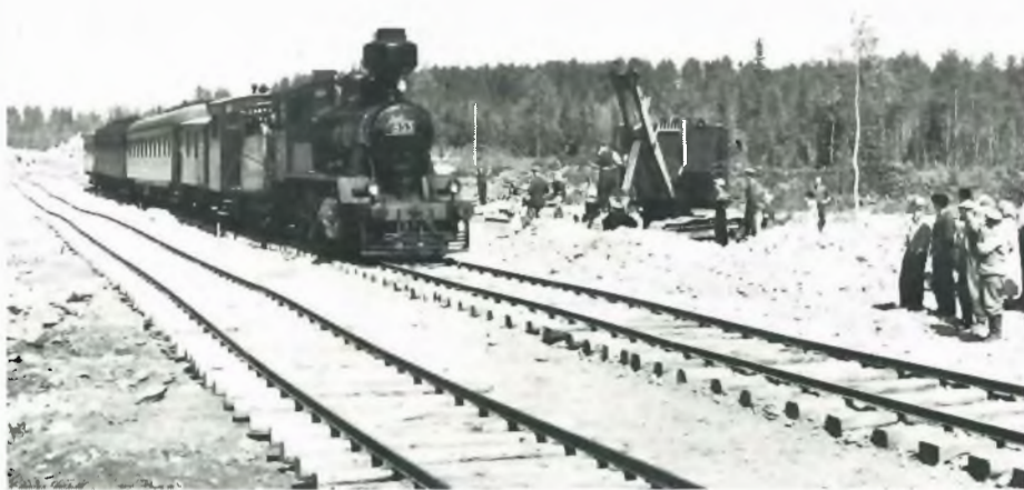
Siilinjärven-Juankosken radan 'harjannostajaisia' vietettiin 1.7.1957. Juhlajuna tuomassa kutsuvieraita ja radan rakentajia työraidetta myöten tulevalle Juankosken ratapihalle.
