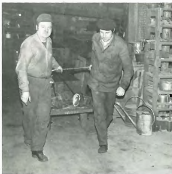
Käsinkaavaus on saatu loppuun. Nyt ollaan matkalla valuun, joka tapahtuu sulatossa.
