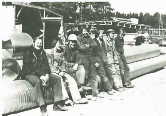
Aeratorin miehiä Kouvolan Karhujen työmaalla vas. työnjohtaja Eino Peippo sekä asentajat Kalevi Tiilikainen, Raimo Pärnänen, Antero Pärnänen, Reino Partanen, Heino Puurtinen ja Markku Parkkonen.
