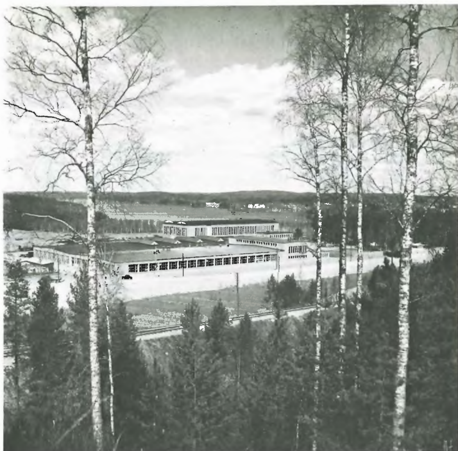
Tehdas kuvattuna v. 1958, jolloin sitä oli laajennettu jo kolme kertaa. Alakuvassa radiaattorihallin runkoa kootaan betonisista pilareista ja kattopalkeista kesällä 1952.
