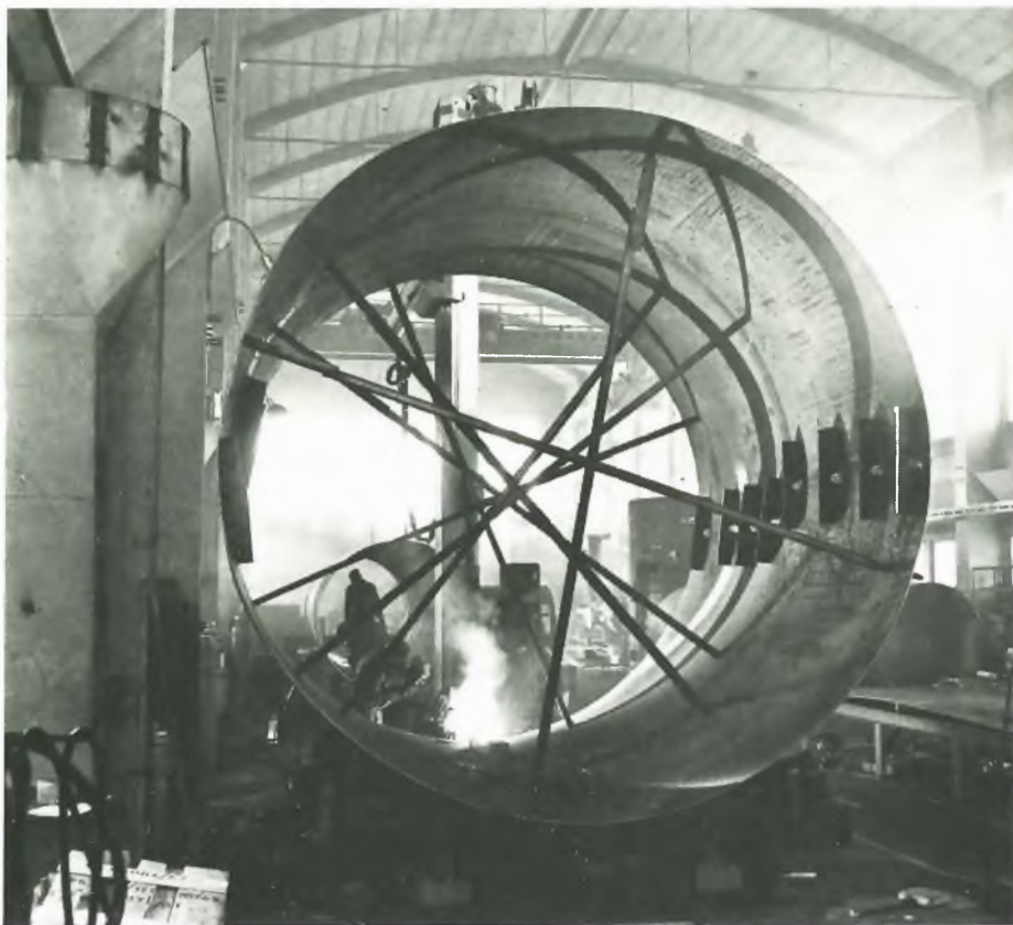
Aluksi valmistettiin teräslevystä keskuslämmityskattiloita kerrostaloja varten, mutta jo 1960-luvun alussa Heinolassa tehtiin maamme suurimmat kaukolämpölaitokset. Heinolan kattilat ovat menestyneet myös ulkomaisessa kilpailussa. Kuvassa kattila alkuvaiheessaan.
