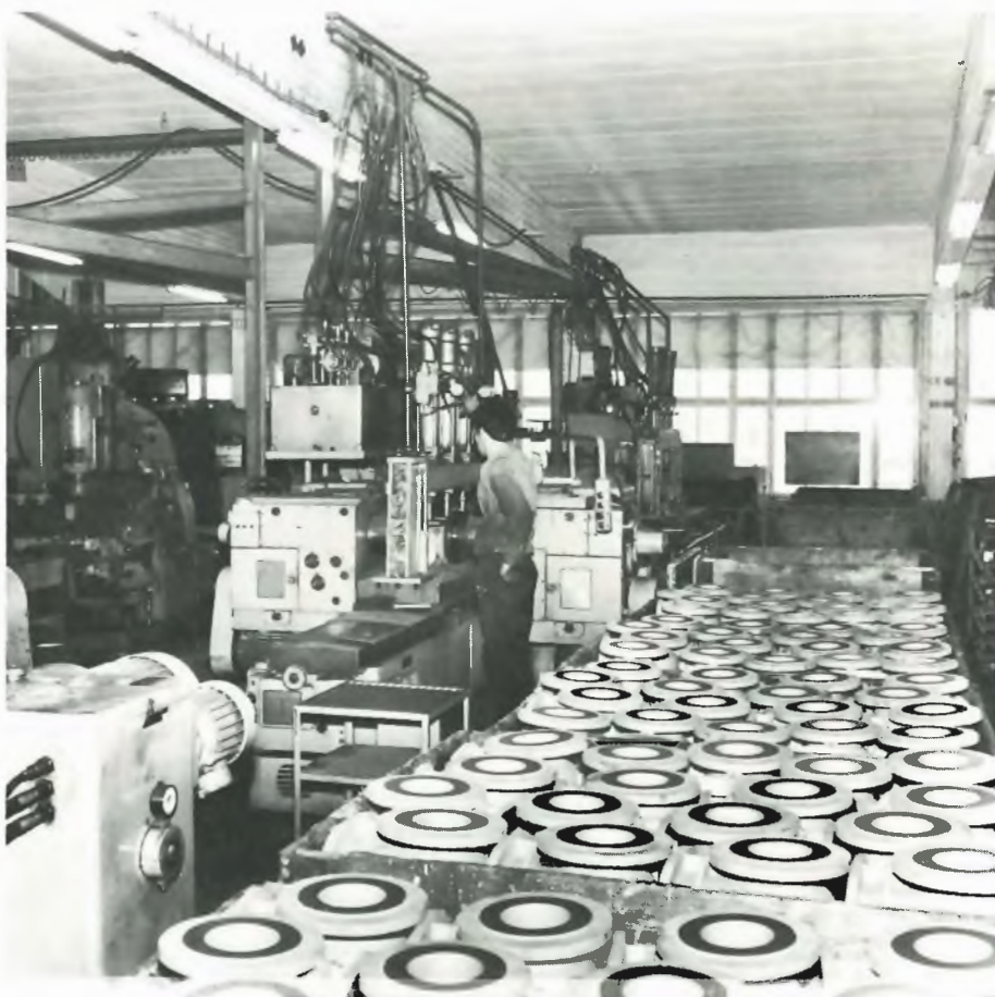
Valurautaventtiilien sarjavalmistusta tehokkaiden koneiden avulla.
