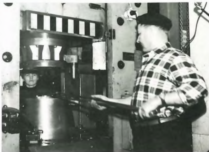
Kuumaa metallia muovataan 250 tonnin puristimen painalluksella.
