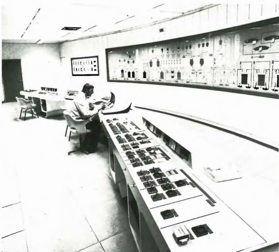
Pastakeittiössä valmistetaan päälystettä molemmille päälystyskoneille. Pitkälle automatisoitu laitos työllistää yhden miehen vuorossa, tällä kertaa Pentti Reimanin.
