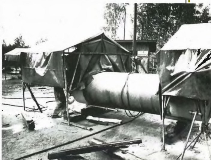
Telaksi muuttuneeseen paateen työstetään päädyt ulkosalla.
