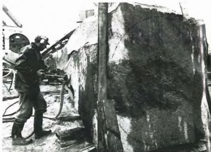
Eero Aholan poraamia reikiä tarvitaan, kun hionnan jälkeen poistetaan liika kiviaines.
