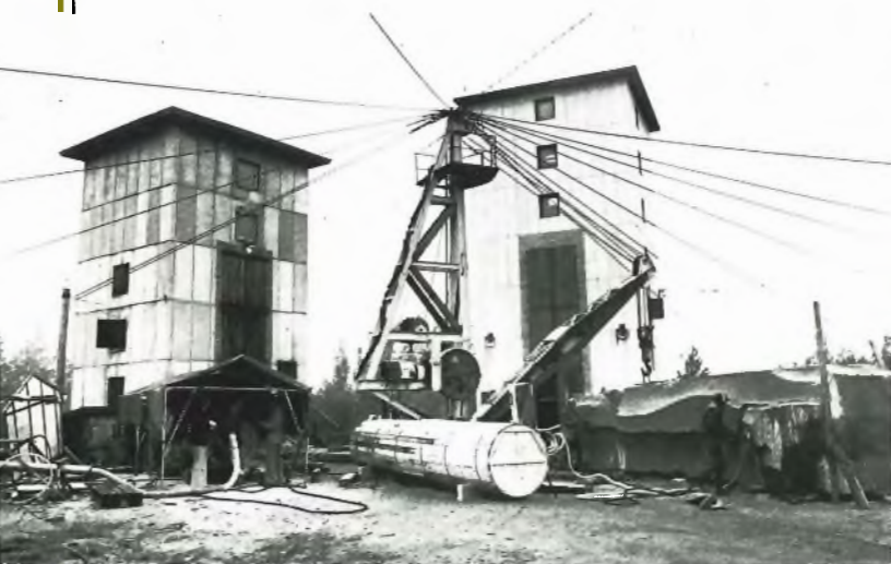
Graniittitelojen sahaustornit ovat jäämässä pieniksi paperikoneiden koon kasvaessa.
