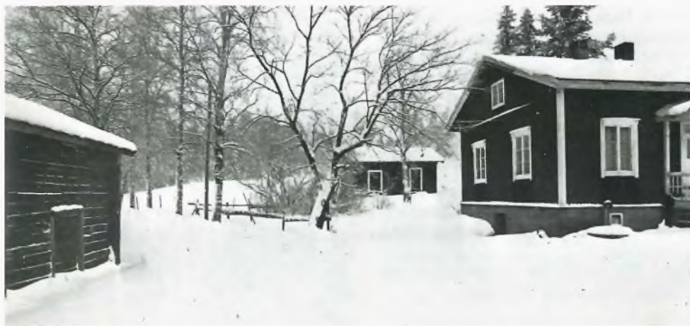
Juutilaisen pihapiiriä, oik. päärakennus, jonka asuinosa on rakennettu v. 1876. Valimo sijaitsee asuinrakennuksen toisessa päässä.
