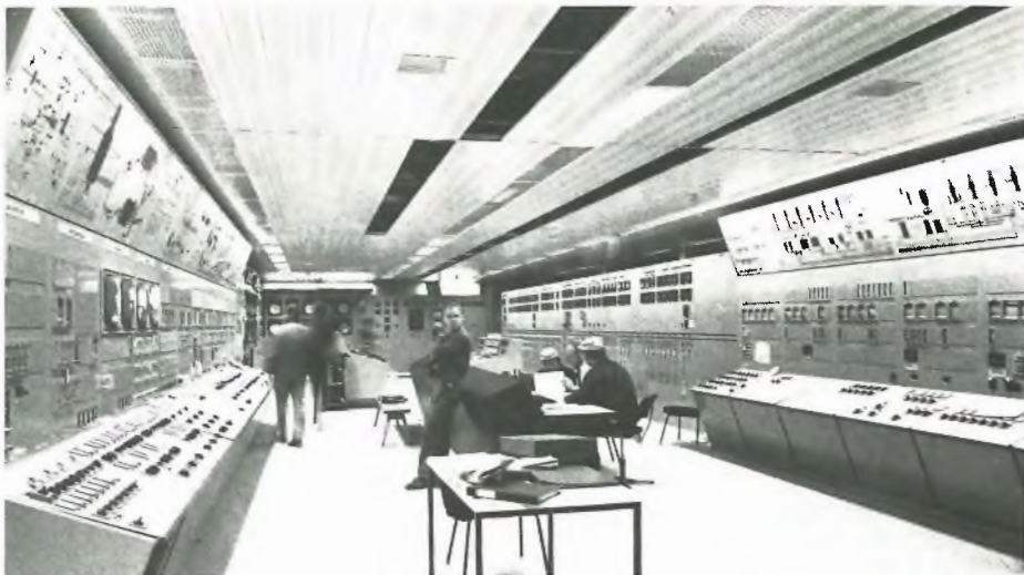
Uuden ja vanhan soodakattilan valvomot on yhdistetty. Etualalla uutta osaa havainnollisine paneeleineen ja tv-monitoreineen.
