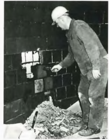
Matti Iiskola työskentelemässä puolilleen täytetyssä keittimessä. Muurausvaihetta ennen on vaurioituneesta kohdasta poistettu tiiliä.
