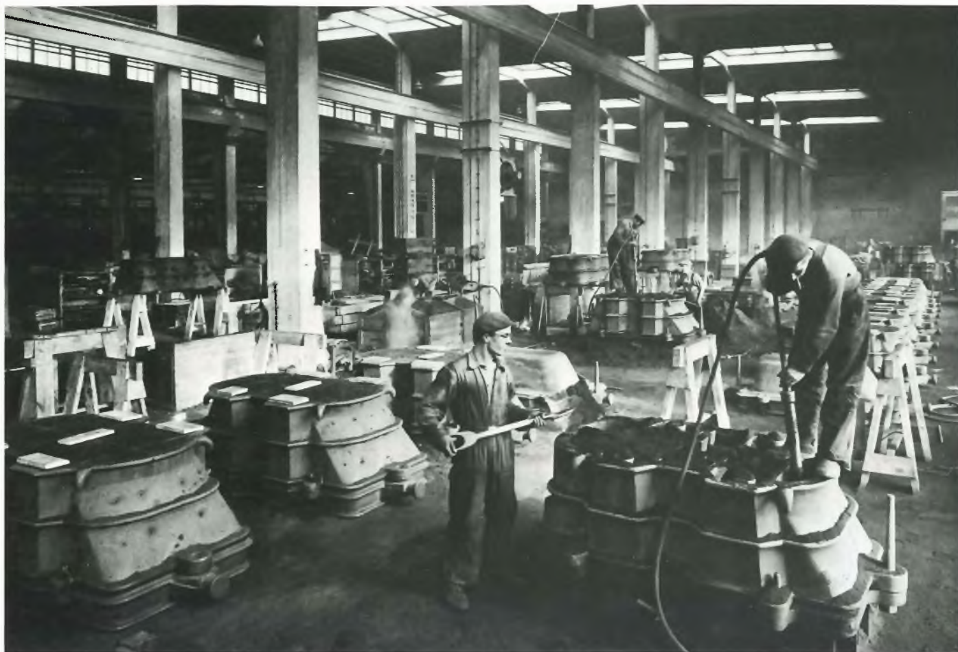
Ammeen syntytarina alkaa kaavauksesta... Vuosien kuluessa kaavaus muuttui käsikaavauksesta konekaavaukseen. Kuvamme amme-kaavauksen alkua ajoilta.
