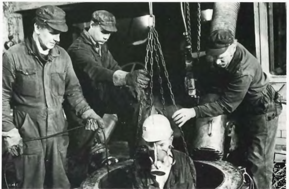
Matti Iiskola työskentelemässä puolilleen täytetyssä keittimessä. Muurausvaihetta ennen on vaurioituneesta kohdasta poistettu tiiliä.
