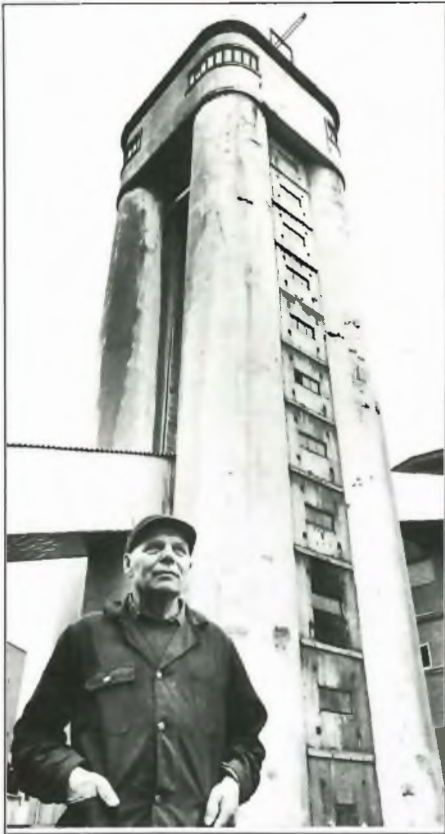
Uljas Villa joutui työskentelemään happotornissa yksinään. Talviaikaan torni oli kylmä työpaikka.
