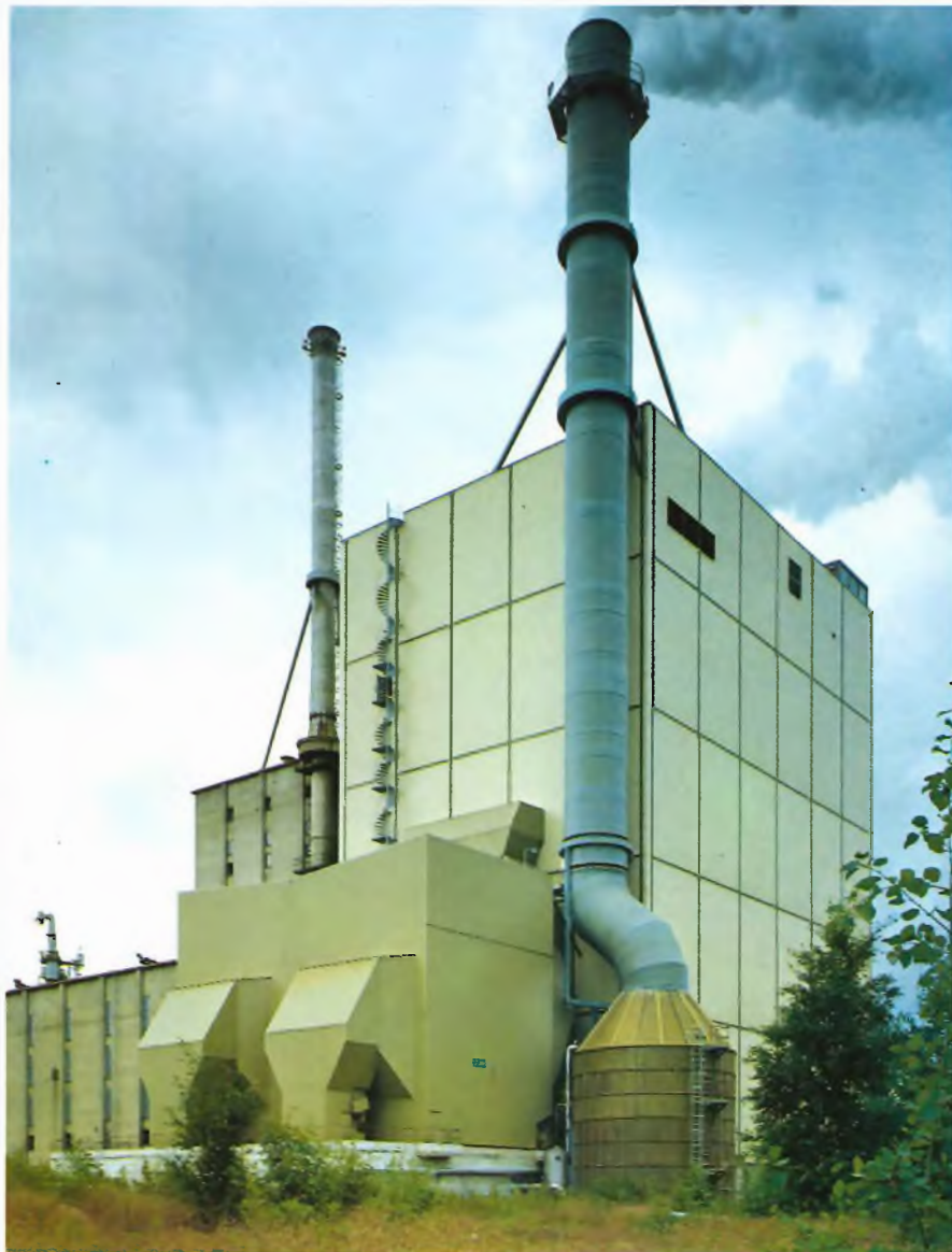
Vanha ja uusi soodakattila sijaitsevat vierekkäin. Sähkösuotimilla, savukaasupesurilla ja -piipulla (etualalla) on suuri luonnonsuojellinen merkitys.
