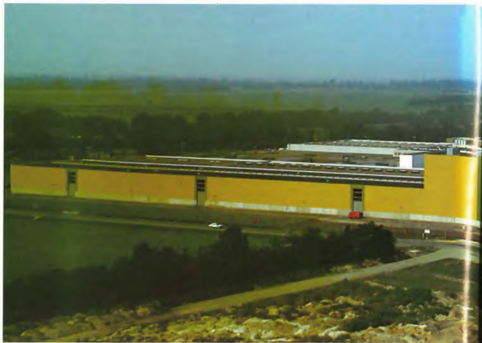
Nordland Papierin uusi paperikone, 135 000 tonnia vuodessa tuottava Liittotasavallan ensimmäinen kaksoisviirakone sijaitsee kirkkaan keltaiseksi maalatussa uudisrakennuksessa. Matalammassa osassa vieressä (vas.) sijaitsevat rullavälivarasto ja valmiiksi pakattujen tuotteiden varasto. Koko kompleksin pituus on lähes 400 metriä.
