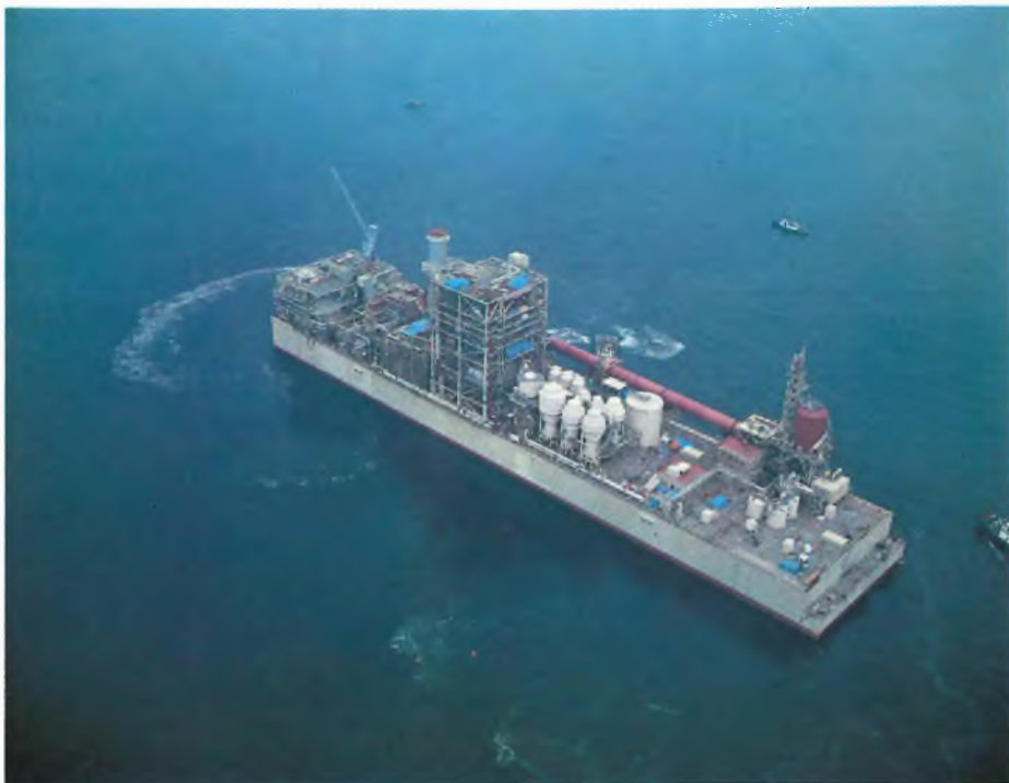
Voimalaitoslautan korkeus on soodakattilan kohdalla 54 metriä, pituus 220 metriä ja leveys 45 metriä. Lautalle on sijoitettu myös haihduttamo, kaustisointilaitos, meesauuni ja kaksi höyrykattilaa. Jari-joella lautalla poltetaan sellutehtaan mustalipeä ja tuotetaan toisaalta höyryä ja sähköä sellutehtaan tarpeisiin.
