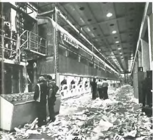
Ohjauspulpetin 'systeemit' testattiin nappi napilta. Vas. ins. Lund, oik. keskellä ins. Holm ja rullamies Jouko Saarela. Alakuvassa on menty jo kuivausryhmän läpi, koska 'kreppipaperia' on lattialla.
