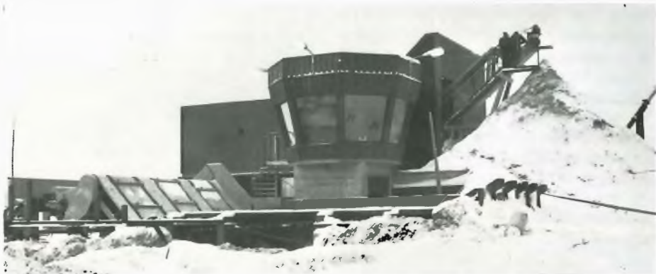
Tukkien vastaanottoa valvotaan uudesta lennonjohtotornin näköisestä rakennuksesta käsin. Etualalla olevan hajoituspöydän jälkeen tukit kuoritaan ja mitataan. Oikealla lämpökeskusrakennukseen johtava kuorijäteputki.
