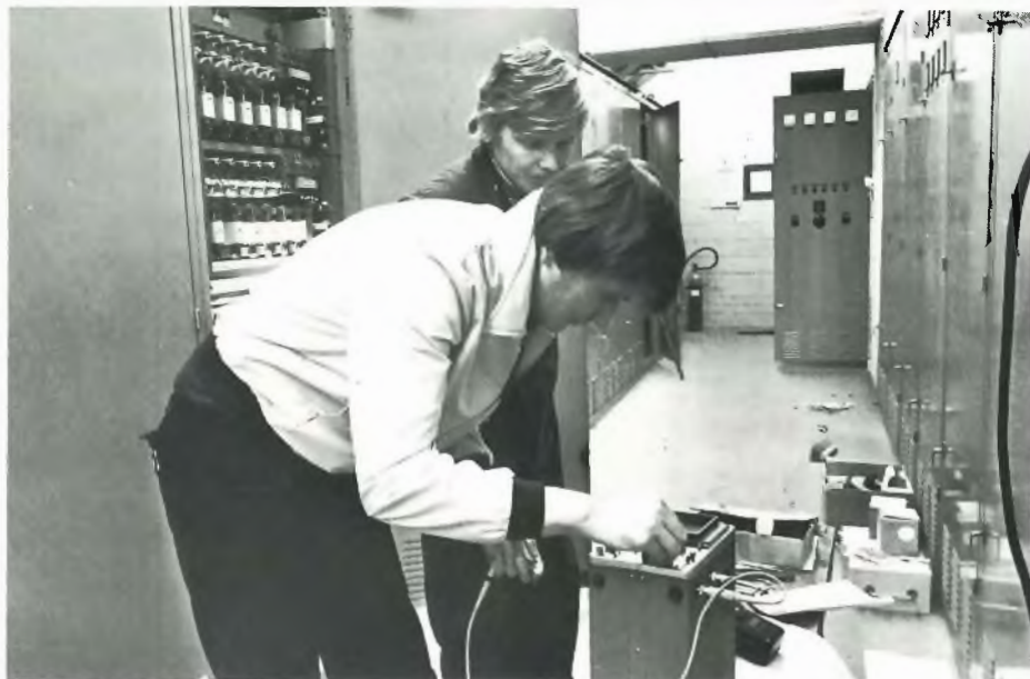
Vikaa etsittäessä Tarmo Metsämuuronen ja Jari Niemi ottivat avukseen oskilloskoopin, jolla mitataan virtaa sytytyspulteista.
