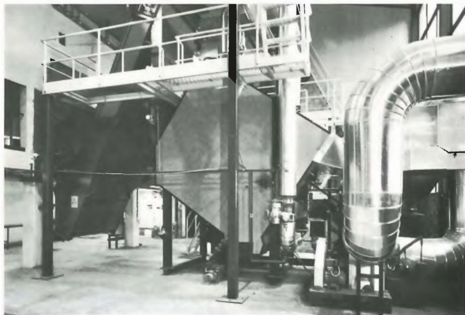
H-36 jet-arina -aluelämpökattila hakkeelle ja turpeelle. Arinassa, jota kattilassa käytetään, on pieniä reikiä, joiden kautta arinailma puhalletaan suihkuna polttoaineeseen. Suihkun (engl. jet) vuoksi on otettu käyttöön jet-arina -nimi.
