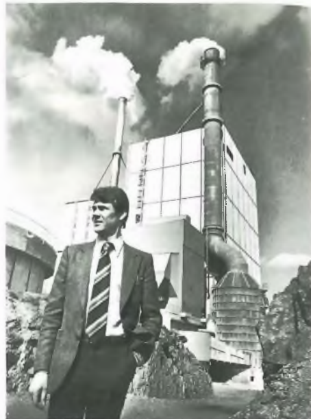
Kuusanniemen sellutehtaan käyttöpäällikkö Pekka Koivisto ja taustalla soodakattila, jonka edessä ovat sähkösuotimet, savukaasupesuri ja -piippu.
