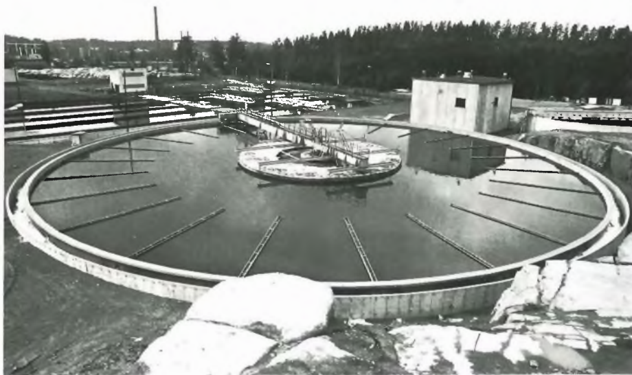
Kuusanniemen sellutehtaalla on tehokas jätevesien puhdistusjärjestelmä. Etualalla tehtaan uuden kolmoslinjan selkeytysallas ja taustalla sellutehtaan vanhemmat jätevesialtaat sekä biologinen puhdistamo.
