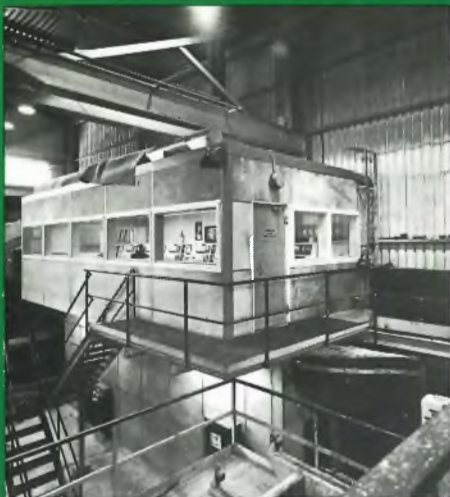
Eristämällä Voikkaan ns. Tampella-hiomon ohjaamo muista rakenteista ja lisäämällä seinien ja ikkunoiden äänieristystä voitiin ohjaamon melua vähentää 14 dB(A):lla.
