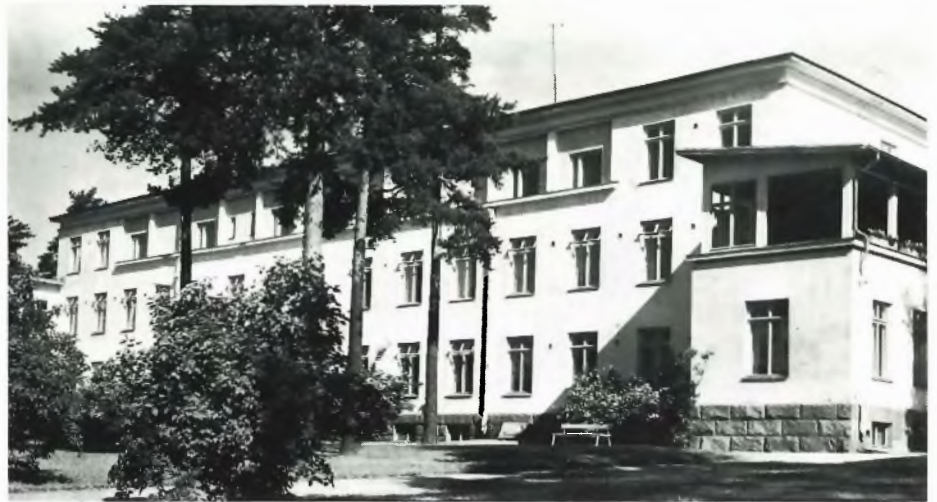
Kuusankosken kunnan ja Kymiyhtiön yhteisesti perustama 50-paikkainen kunnallinen keuhkotautiparantola valmistui Naukionmäelle vuonna 1933.
