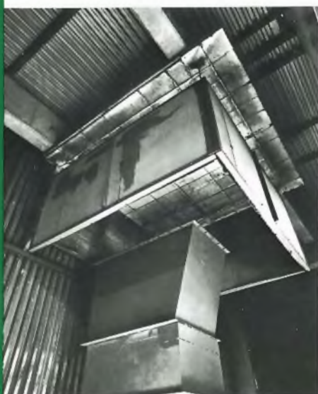
Voikkaan höyryvoimalaitoksen kattila K13:n ilmanottoaukon päälle rakennettu meluloukku vähensi melua alueella 12 dB(A).
