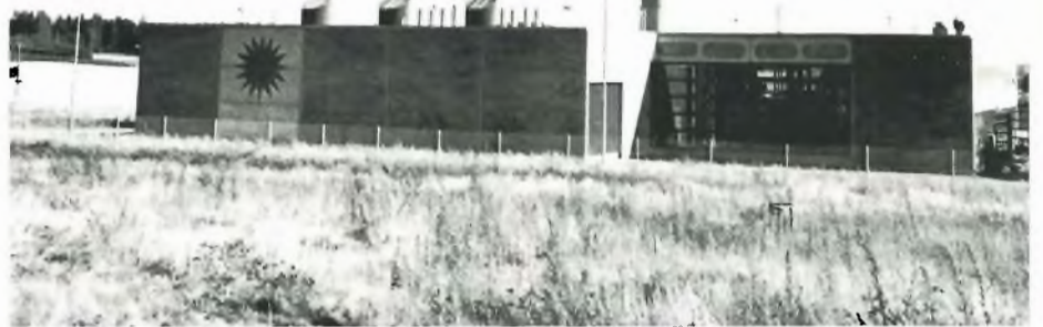
Kymi Kymmene Metallin tehdas on toimittanut useita turvekattiloita kotimaisille lämpölaitoksille. Ahveniston lämpökeskus Hämeenlinnassa käyttää polttoaineena mm. turvetta.
