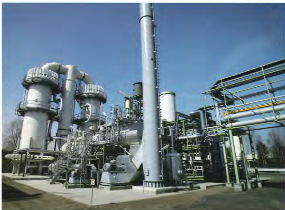
Merkittävä osa uudistettua tuotantolaitosta on kuvassa oleva uusi vetylaitos, jossa valmistetaan maakaasusta vetyperoksidin toista raaka-ainekomponenttia, vetyä.
