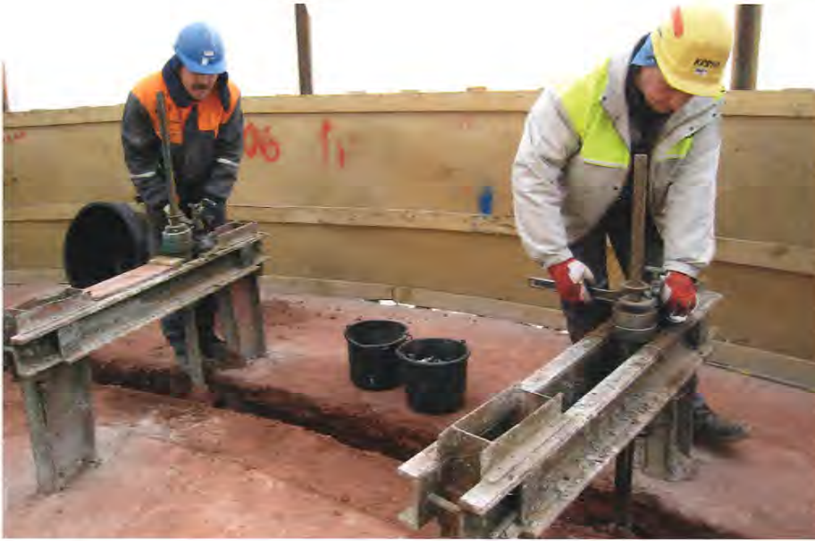
Tunkkipukit pitivät muotin puoliskot kasassa ja toisiinsa nähden linjassa, sekä takasivat muotin tasaisen nousun. Valumuotti oli puurunkoinen ja peltivuorattu. Sitä nostettiin hydraulitunkeilla aste asteella.
