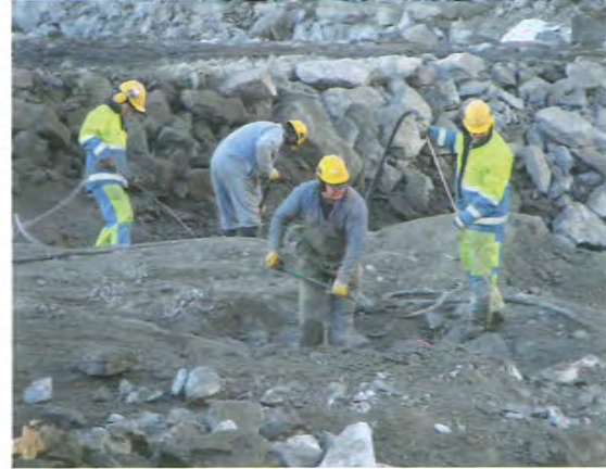
Työmaalla oli 2.12. menossa kallion rusnaukset. Rusnauksessa poistetaan kallion pinnasta heikko kivimateriaali kuten suurimmat irtonaiset kivet.
