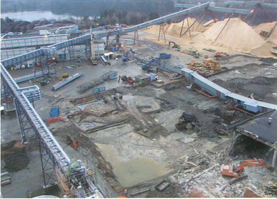
Työmaalla oli 2.12. menossa kallion rusnaukset. Rusnauksessa poistetaan kallion pinnasta heikko kivimateriaali kuten suurimmat irtonaiset kivet.
