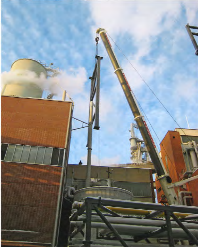
Ensin matkasi putkisiltalohkon jalka ja vierisessä kuvassa putkisiltalohko ylittää katon hyvin läheltä hönkäputkea.
