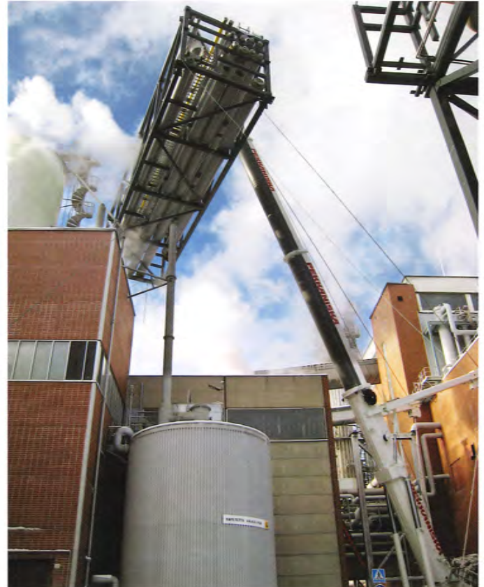
Ensin matkasi putkisiltalohkon jalka ja vierisessä kuvassa putkisiltalohko ylittää katon hyvin läheltä hönkäputkea.
