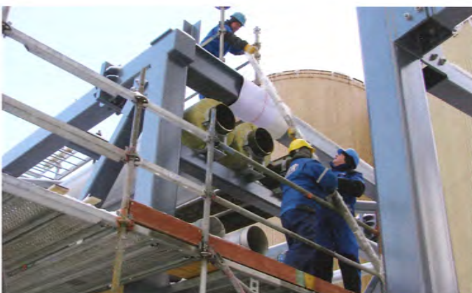
Siltalohkon kasausta (ylempi kuva). Kaapelihyllyjä asennetaan siltalohkoon sähkömiesten tarpeisiin (alempi kuva).
