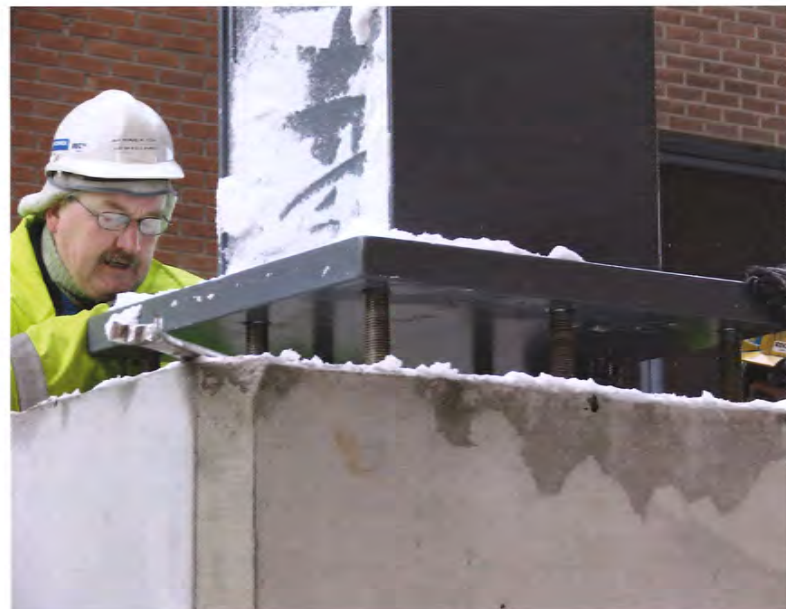
Nostopäivänä Heikki Laine totesi peruspultit hyvin mitoitetuiksi ja jalka asettui hyvin paikoilleen.
