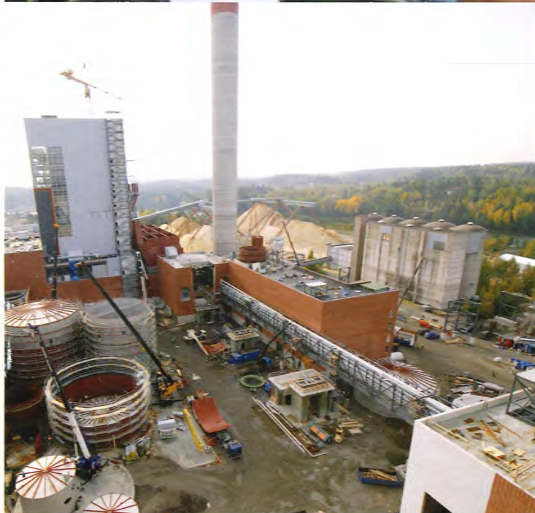
Kuvassa keskellä 80-metrin korkeuteen noussut soodakattila, sen vasemmalla puolen turbiinilaitos. Vasemmalla haihuttamon ja oikealla kaustistamon aluetta. Talteenoton piipun korkeus on noin 130 metriä.
