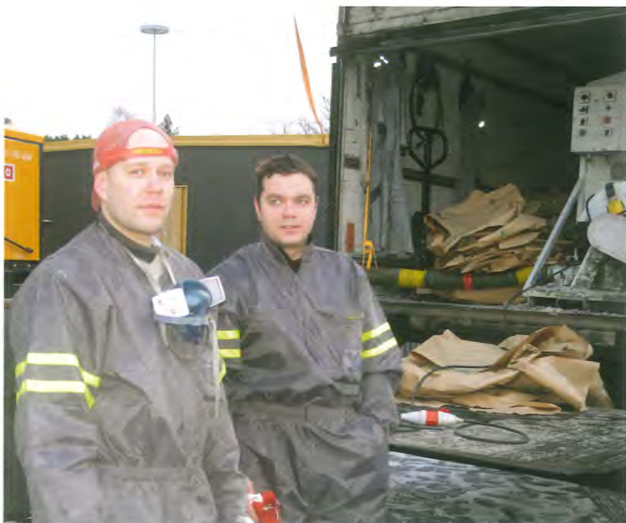
Haastattelupäivänä Kimmo (vas.) ja Petri olivat puhaltamassa selluvillaeristettä Jaalan S-Marketin laajennusosan ullakolle.
