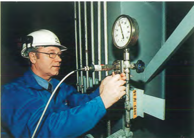
Matti Tikka (vasemmalla) ja Raine Rantanen tarkistamassa kattilan yläosan putkien tiiviyyttä.
