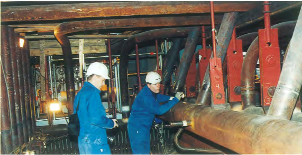
Matti Tikka (vasemmalla) ja Raine Rantanen tarkistamassa kattilan yläosan putkien tiiviyyttä.
