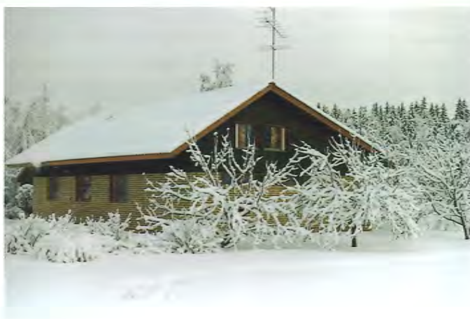
Rintamamiestonttien ensimmäinen rakennus, jonka rakensi Tauno Kukkurainen Kytöahontielle vuonna 1951 (ylin kuva). Heikki Purho osti talon ja laajensi sen nykyiseen kokoonsa vuonna 1977 (alin kuva).
