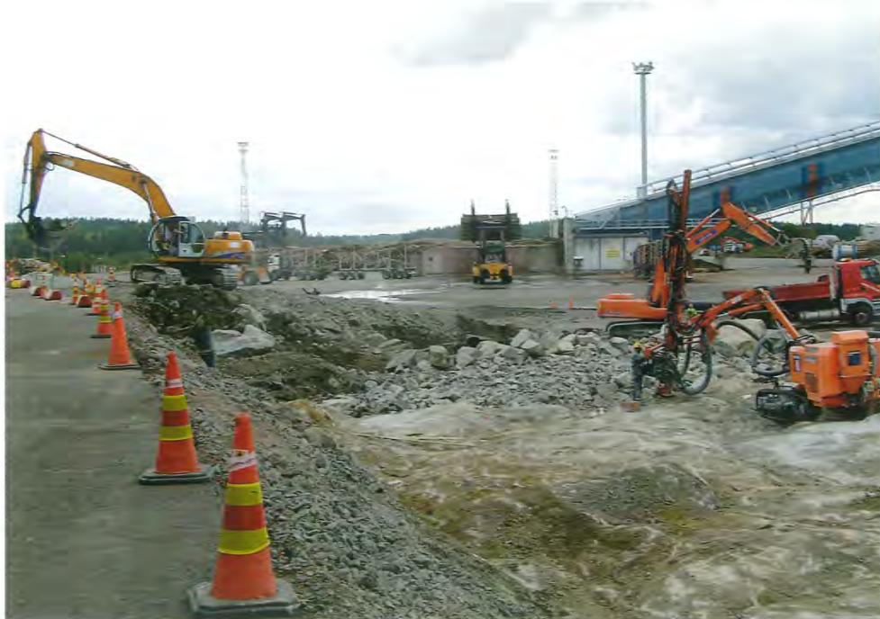
Kuusanniemen tuontipuutermiinalin rakennustyömaalla oli elokuussa menossa maansiirto- ja kaivaustyöt.
