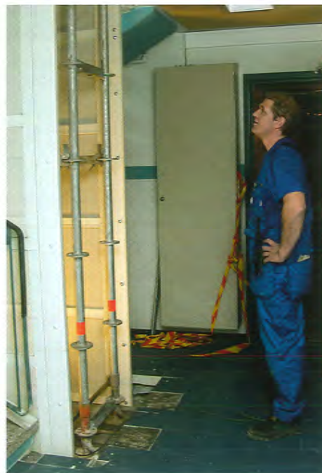
Kahden talon jokaiseen rappukäytävään rakennetaan hissit.
