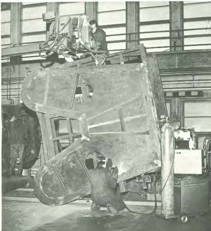
Helmikuun puolivälissä valmistui Heinolan tehtaalla suuri teräsrakenteinen hammasvaihdeiston kotelo. Kotelo kuljetettiin Heinolasta autolla Tampereelle, missä Tampella Oy hehkuttaa sen ja koneistaa laippojen tasopinnat. Tämän jälkeen kasataan koteloon vaihteisto Santasalossa. Vaihteisto sijoitetaan valssilaitoksen käyttökoneistoon.
