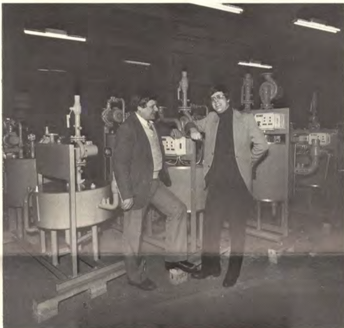
Myyntipäällikkö Kai Tormo ja tuotepäällikkö Timo Väli-Torala valmiiden lämmönjakokeskusten rivistössä. Yhdessä lämmönjakokeskuksessa näkyvät kaksi ”pönttöä” ovat kuparierukkalämmönsiirtimiä. Suurempi pöntöstä lämmittää kiinteistön, pienemmässä lämpenee käyttövesi.
