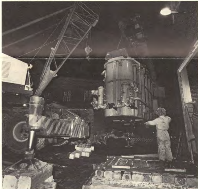
90 tonnia painava muuntaja nostettiin kuljetusalustalta kahden nosturin voimin. Sisätiloihin se siirrettiin etualalla näkyviä kiskoja pitkin.
