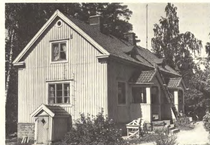
Järvisen talon ulkoasu kattoikkunoita myöten säilyy ennallaan. Ainoastaan katon materiaali vaihtuu.
