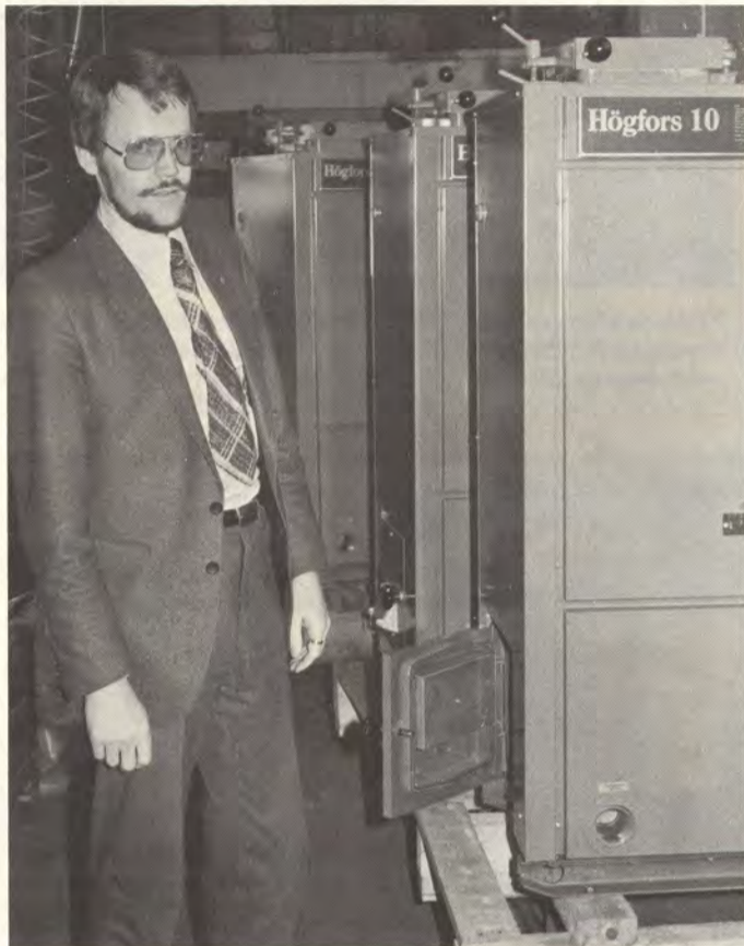
Diplomi-insinööri Väinö Aro hoitaa Kymin Metallissa tuotantotekniikan kehittämiseen, investointeihin ja tuotekehittelyyn liittyviä asioita. Kuva Karkkilan tehtaan kattilalinjalta; Högfors 10 on alapaloinen varastopesäkattila kiinteille polttoaineille.
