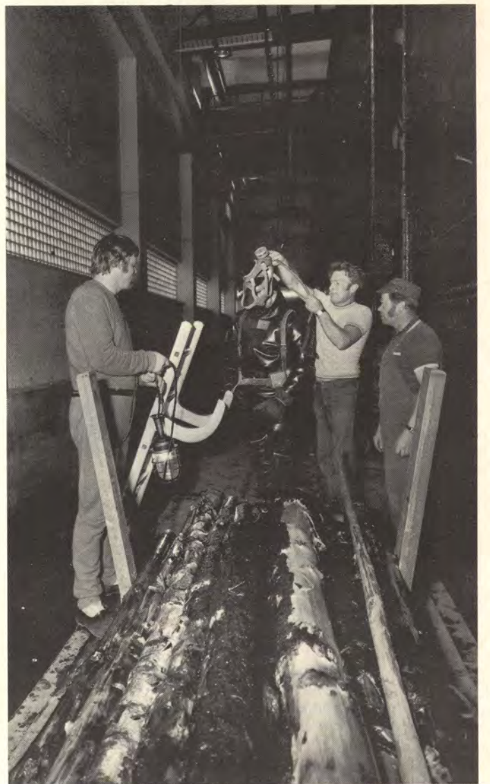
Rakennusosaston sukeltaja Hannu Kotilainen lähössä Kuusankosken vesivoimalaitoksen uomaan puhdistamaan välppiin eteen muodostunutta propsumaa, vas:lla lepovuorossa oleva sukeltaja Hannu Kilkki, narumiehinä Ossi Fält ja Jussi Vierula (äärim. oik:lla).
