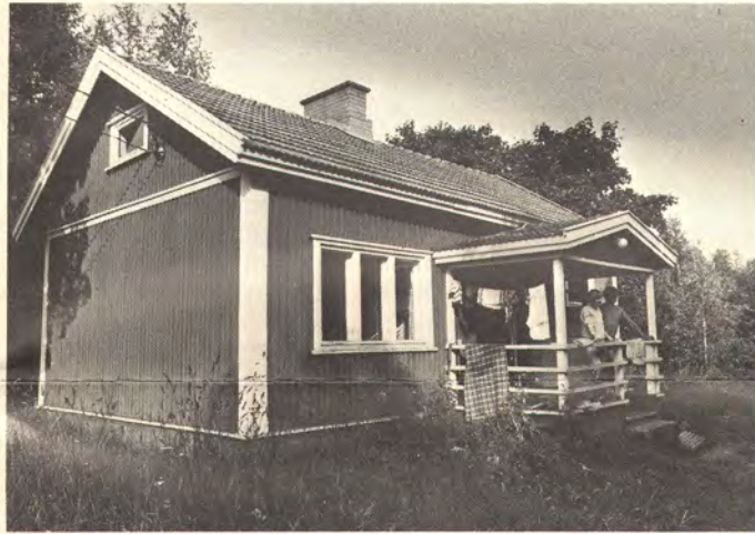
Salmenkorvan päärakennus on hyvässä kunnossa.
