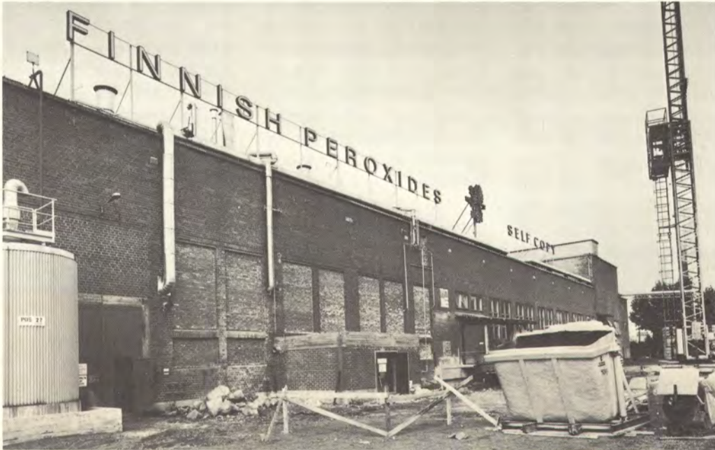
Peroksiditehtaan laajennusosasta tulee 250 m 2 :n laajuinen. Se rakennetaan tehdasrakennuksen "julkisivun" puolelle. Valmistelevana työnä on vanhan rakennuksen ikkunat jo muurattu umpeen.
