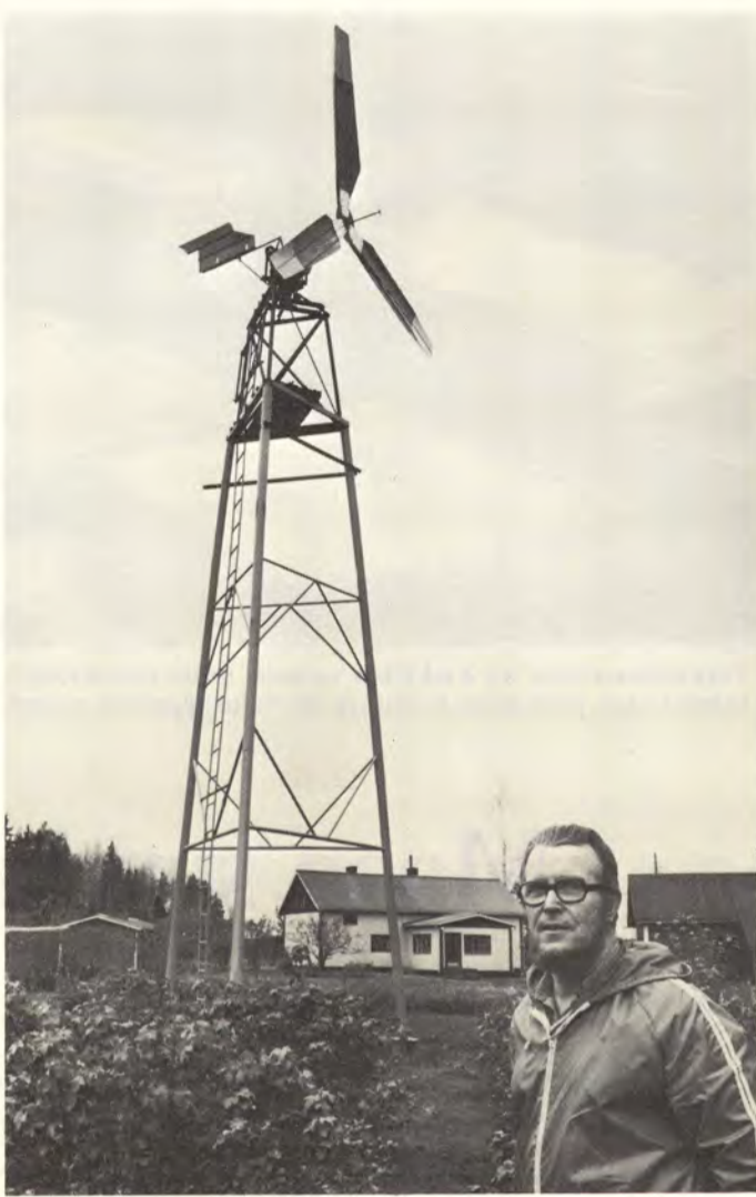
Tenho Hallikkaan tuulivoimalan siivet ovat kolmen metrin mittaiset. Generaattorin nostaminen torniin vaati apuvoimia, muuten hän on tehnyt laitoksensa kokonaan yksin.
