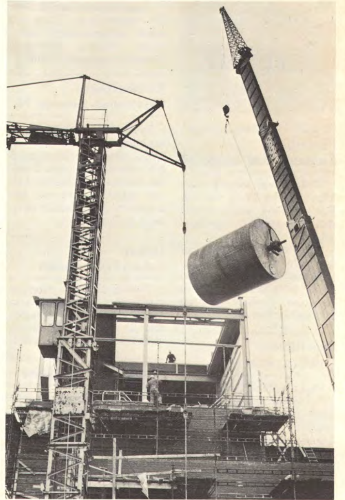
Rejekttilaitos (ylh.) on rakennettu entisen PK 14:n massaosaston kohdalle, mutta lähes 20 metrin korkeudelle. Kuvassa meillä saostajan rummun nosto. Rumpu on halkaisijaltaan 3,5 metrin ja 4,5 metriä pitkä. Se nostettiin 25 metrin korkeuteen.
