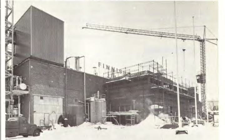
Peroksiditehtaan laajennusosa sulautuu hyvin vanhaan osaan, sillä verhoilumateriaali molemmissa on punainen tiili.
