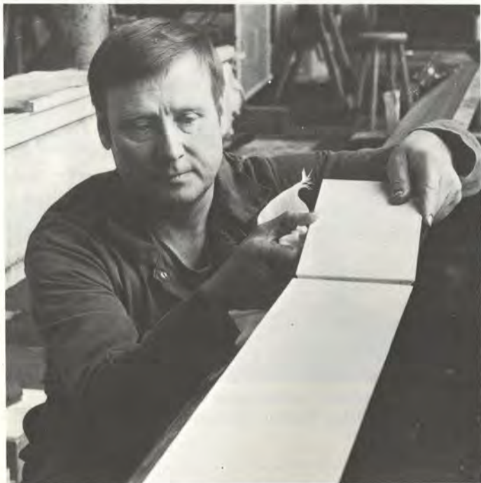
Teuvo Vanhalakka asentamassa keramiikkalevyjä.
