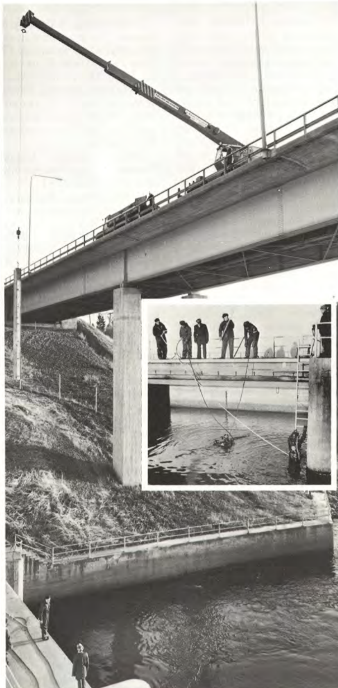
Voimalan alapuolelle ns. imuputken suulle laskettiin parrut estämään veden pääsy vesiteihin. Ylhäällä Keltin silta.
